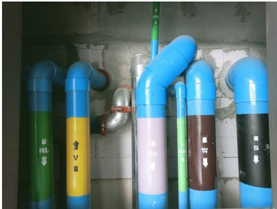
รูปที่ 27 ท่อรวบรวมน้ำจากห้องพักมูลฝอย
