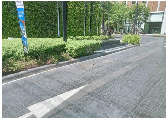
รูปที่ 48 บ่อพักน้ำสุดท้ายก่อนระบายออกสู่ทางระบายน้ำสาธารณะ
