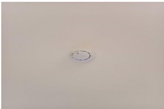
ที่ 51 เครื่องตรวจจับควันภายในห้องไฟฟ้า
