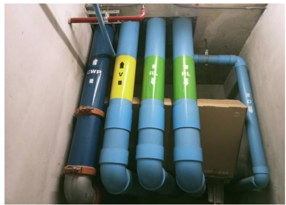
รูปที่ 27 ท่อรวบรวมน้ำจากห้องพักมูลฝอย
