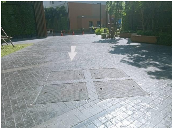
รูปที่ 48 บ่อพักน้ำสุดท้ายก่อนระบายออกสู่ทางระบายน้ำสาธารณะ
