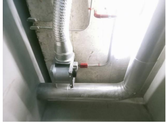
รูปที่ 26 เครื่องดูดอากาศภายในห้องพักมูลฝอยเปียก
