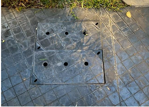
รูปที่ 46 ท่อระบายก๊าซมีเทน
